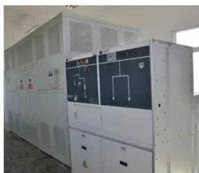
图2-23 集中式三相并网逆变器应用现场
