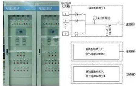
a) 直流配电柜外观 b) 直流配电柜电气连接图 图2-19 直流配电柜外观和电气连接图
